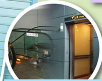
升降機及自動梯裝置 Lift & escalator installation
